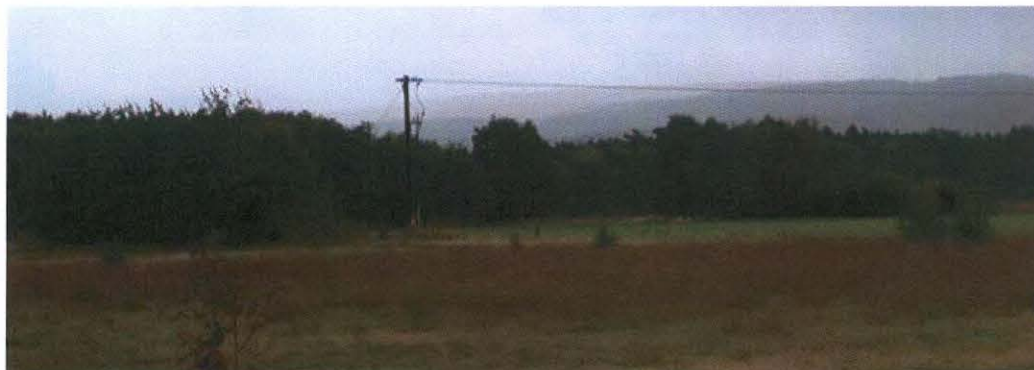
Befintlig 20-kilovoltsledning som korsar detaljplaneområdet.
