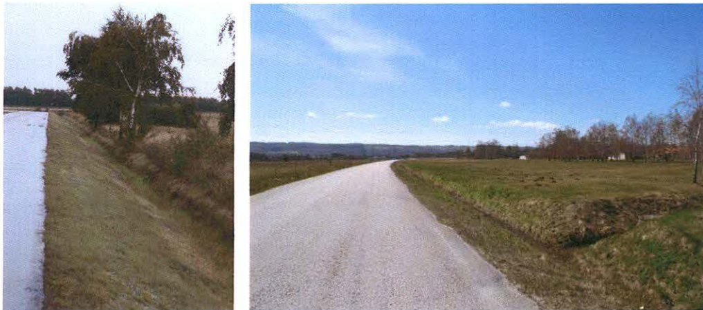
Allarpsvägen norr om detaljplaneområdet.
